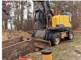
Podpisanie umowy z wykonawcą infrastruktury kanalizacyjnej – firma BKW Bogdan Tarnowski
